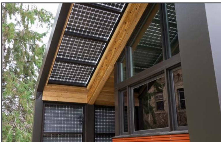
L'inclinaison idéale d'un panneau solaire dépend avant tout de son fonctionnement. Ainsi, les modèles photovoltaïques exigent un angle de 30° par rapport à l'horizontale (à défaut, le placer à l'horizontale), tandis que les systèmes thermiques privilégient une pente de 45° à 50° par rap-
