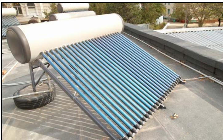
La composition des différents modèles de chauffe-eau solaire est à peu près identique, mais dépend du mode de transfert de l'énergie. Ainsi, les modèles à thermosiphon, à circulation libre ou à éléments séparés ne possèdent pas de circulateur ni de régulation. En revanche, sur
