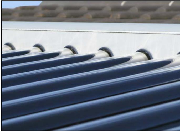
Les panneaux solaires thermiques, placés par exemple sur le toit de l'habitation, sont ensuite reliés à un système situé à l'intérieur du logement. Il se compose alors d'un circuit hydraulique, contenant un **liquide caloporteur** qui relie les panneaux au reste de l'installation, un système d'énergie d'**appoint** pour relayer l'énergie
