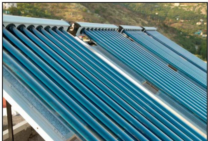
derniers sont ici distincts et distants. Le ballon est alors placé plus haut que les capteurs afin que l'eau chaude s'élève naturellement. Ce dispositif fonctionne par ailleurs sans électricité et réclame peu d'entretien.
