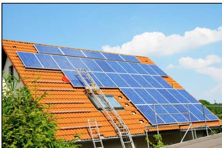
Le panneau solaire orienté plein sud avec une inclinaison de 30° par rapport à l'horizontale est la solution idéale. Mais en pratique, il faut bien composer avec l'architecture de l'habitation, la présence d'ombres projetées (arbres, clochers, immeubles en vis-à-vis), etc. Une tolérance est donc accordée : le
