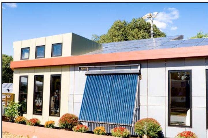
Sur un toit, des panneaux solaires **intégrés au bâti** sont utilisés comme matériaux de construction. Ils remplacent les tuiles, façades de balcon, pare-soleil, etc., et constituent une partie de la toiture ou des murs, voire de la verrière. Cela est toutefois possible uniquement pour les bâtiments en construction. Cela vous permet également de bénéficier d'un tarif de rachat de l'électricité plus élevé.
